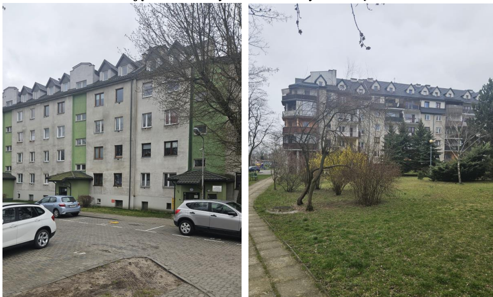
Zdjęcia 4-6: Budynek mieszkalny z zewnątrz.
