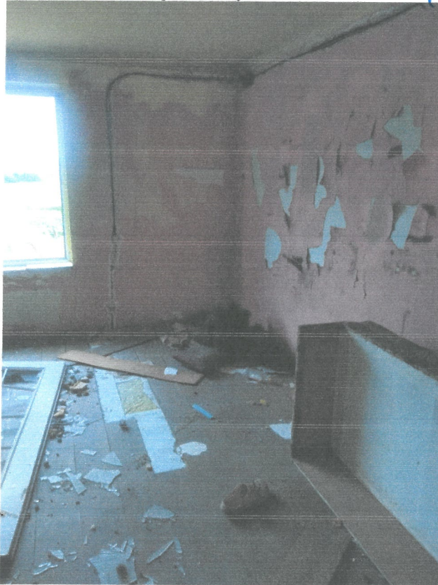
wyrwana instalacja elektryczna
