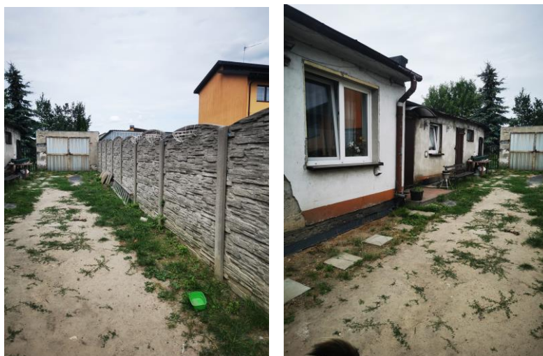
Zdjęcia 13-14: Budynek gospodarczy z zewnątrz.
