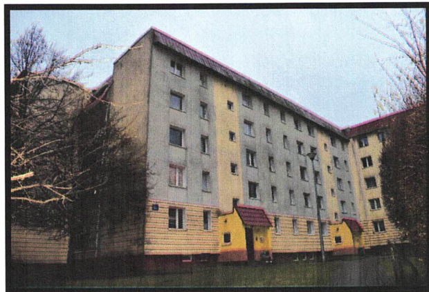
Obraz 5: Widok budynku położonego przy Jagiełły 6A
